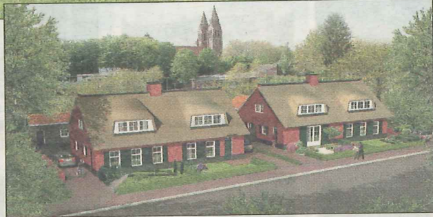
De bouwstijl van deze boerderijen verwijst naar het verleden van Laren.
